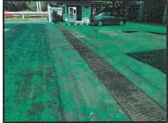
รูปที่ 3.1-11 บ่อพักน้ำเสีย ความจุไม่น้อยกว่า 7.1 ลูกบาศก์เมตร
