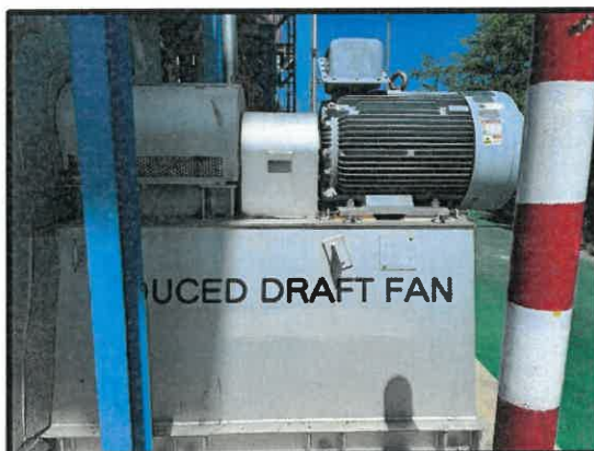
รูปที่ 3.1-3 แผ่นรองกันสะเทือนหรือมีฝาปิดครอบ เพื่อลดแรงสั่นสะเทือน
