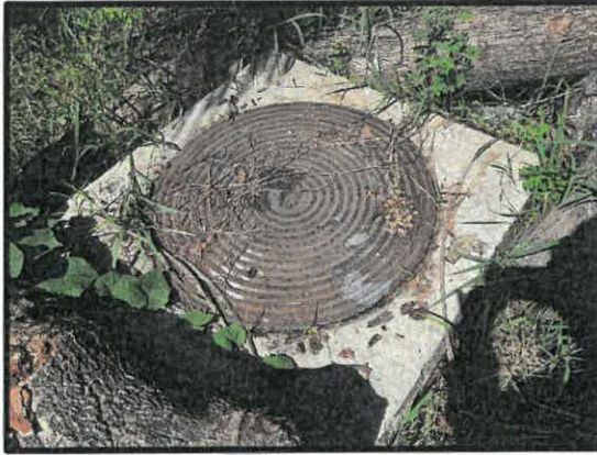
รูปที่ 3.1-10 รูปบ่อเกรอะ (Septic tank) และบ่อน้ำทิ้ง
