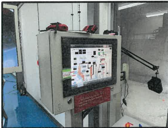
รูปที่ 3.1-2 ตู้ควบคุมอุณหภูมิในการเผา 800 - 1,200°C
