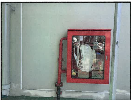
รูปที่ 3.1-26 ตู้ดับเพลิงภายในพื้นที่โครงการ
