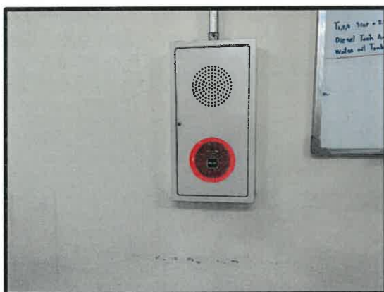
รูปที่ 3.1-28 อุปกรณ์เตือนภัยเมื่อเกิดเหตุไฟไหม้
