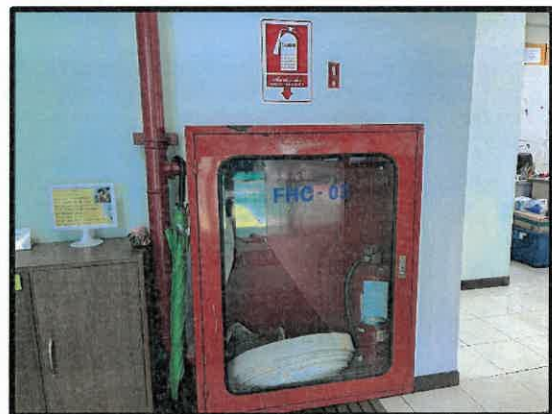
รูปที่ 3.1-26 ตู้ดับเพลิงภายในพื้นที่โครงการ
